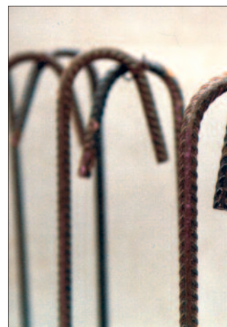
Bild 3: Steckseisenendhaken zur Wandmitte ausrichten
