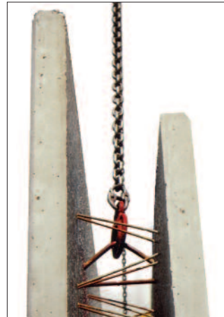
Bild 4 und 5: Element an den vorgesehenen Anschlagmitteln anhängen
