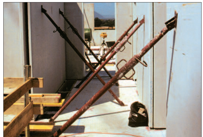
Bild 16: Sicherung der Wandelemente mit Schrägstützen
