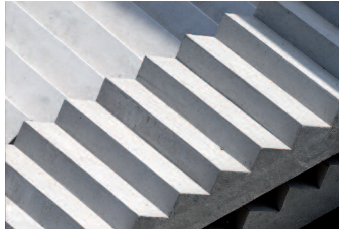
Bild 14: Gerade Beton-Fertigteiltreppe
