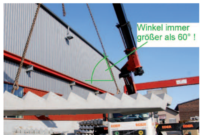
Bild 6: Neigung der Ketten muss größer als 60° sein!
