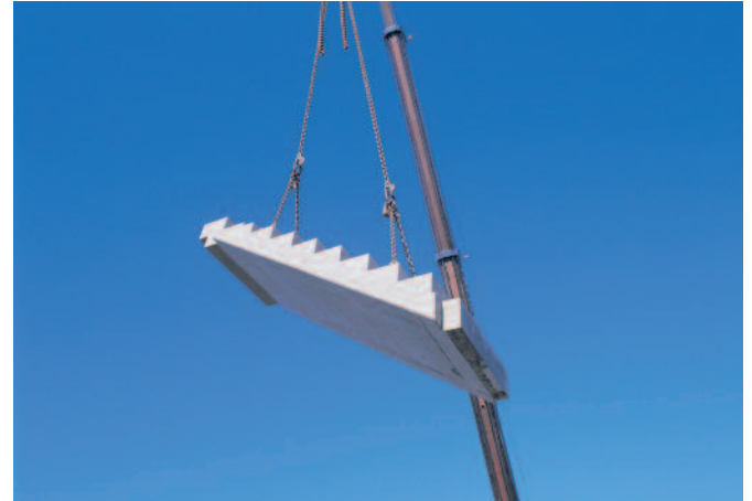
Bild 10: Beton-Fertigteiltreppe am Montagekran
