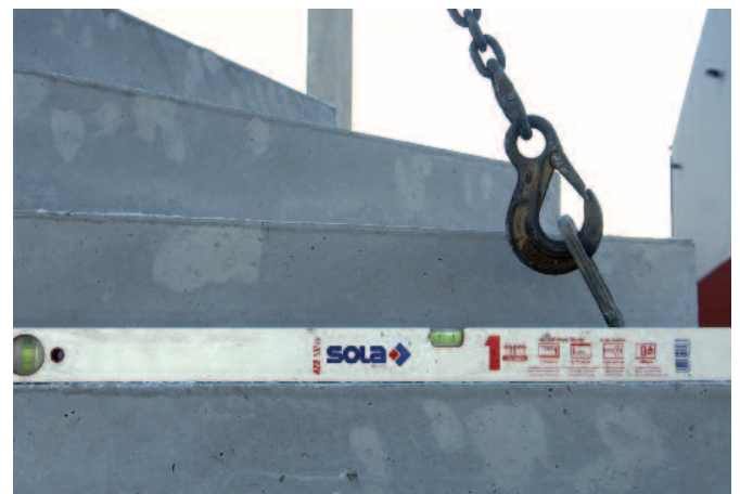
Bild 12: Stufen müssen quer zur Laufrichtung waagrecht liegen
