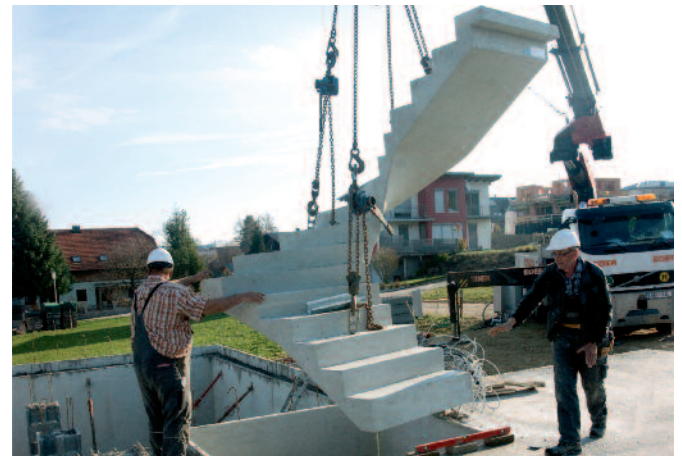
Bild 11: Einheben der Treppe in Montagelage
