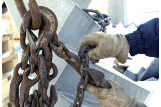
Bild 4: Anlegen des Montagegehänges
