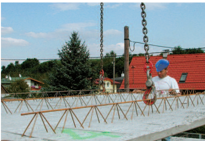
Bild 13: Einheben eines Deckenelementes
