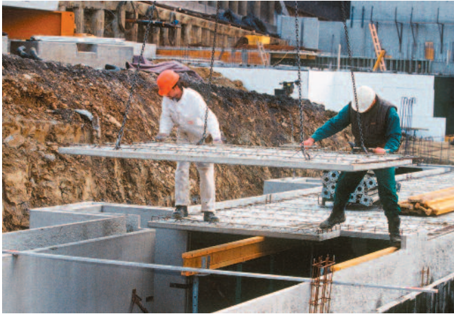
Bild 15: Verlegen der Deckenelemente
