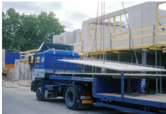
Bild 14: Abladen der Elemente
