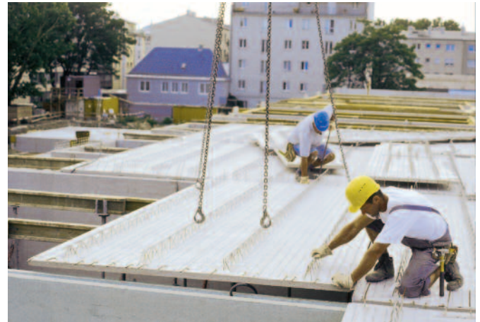
Bild 8: Verlegen der Deckenelemente
