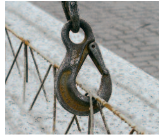
Bild 5: Kranhaken in Knotenpunkten der Gitterträger einhängen
