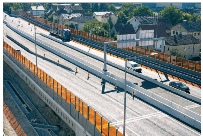
Bild 19: Mittelabsicherung auf Brücke
