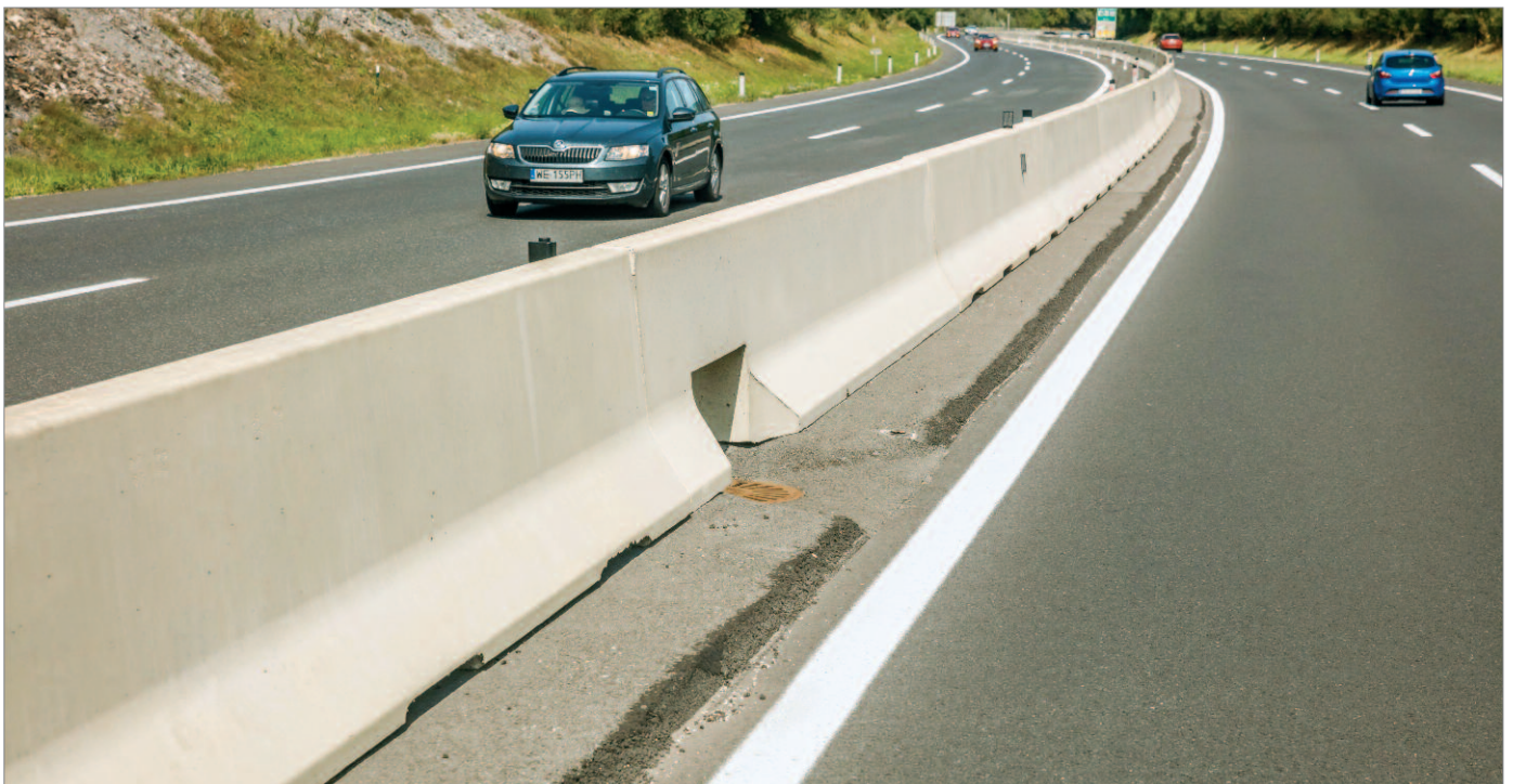
Bild 45: Ausnehmung in der Betonleitwand über Einlaufgitter
