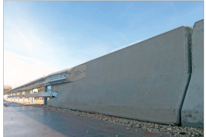
Bild 26: geprüfte Übergangskonstruktion gemäß ÖNORM EN 1317-4
