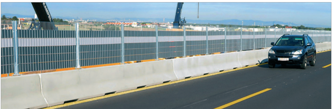
Bild 35: Leitwandsystem mit kombiniertem Sicht-, Blend- und Spritzschutz
