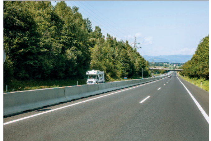
Bild 13: Leitwand innerhalb des Mittelstreifens
