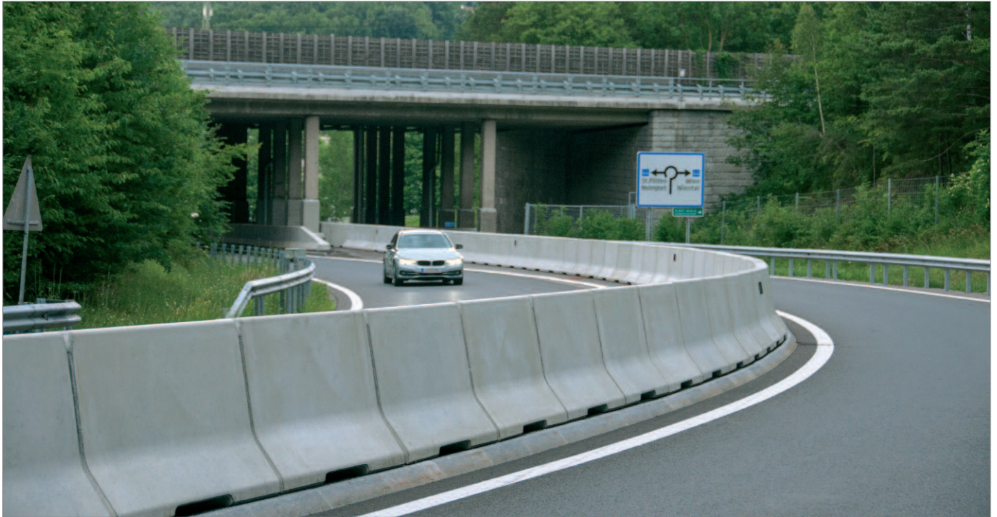
Bild 44: Kurvenausbildung mit kurzen Elementen bei engen Kurvenradien
