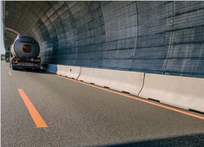
Bild 12: integrierte Entwässerungsöffnungen
