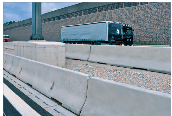
Bild 5: Absicherung eines Hindernisses mit verdorntem System
