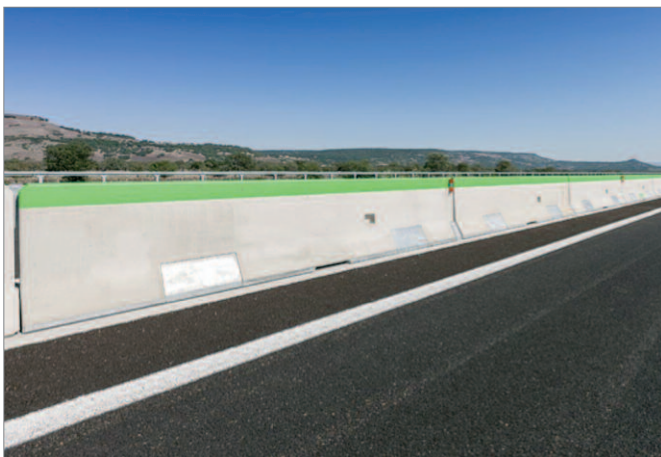
Bild 22: Elemente für Notfallöffnung (grün markiert)
