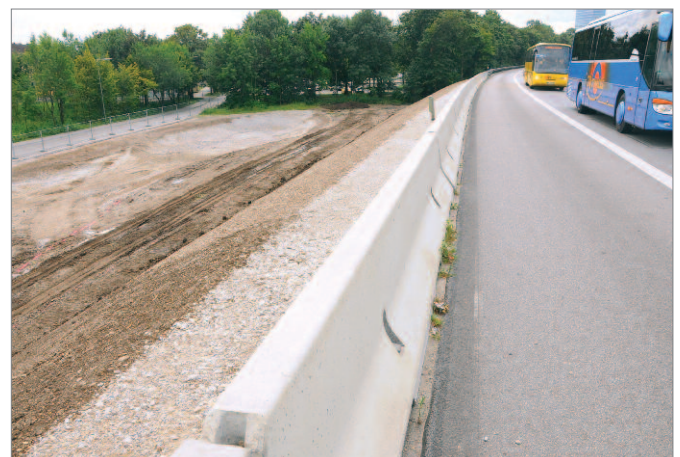
Bild 24: verankertes System an Böschung
