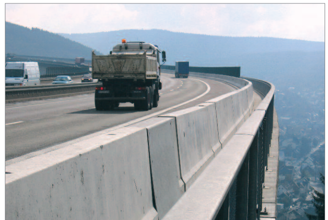
Bild 25: Randabsicherung auf Brücke inklusive Dilatation
