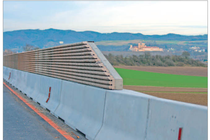
Bild 31: Leitwandsystem mit kombinierter Lärmschutzwand
