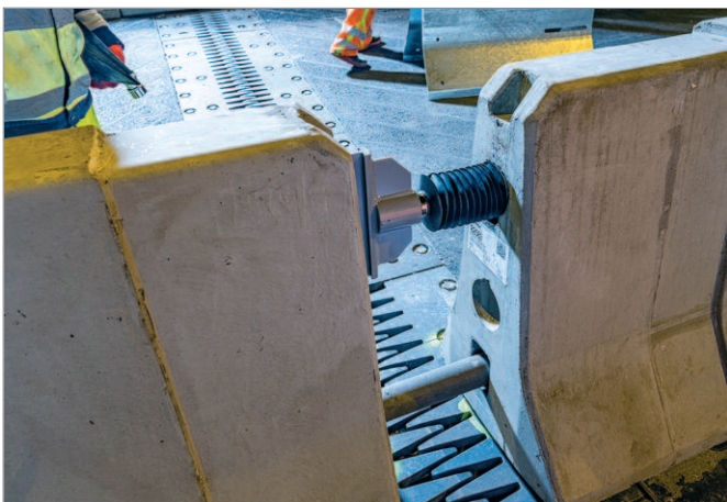
Bild 20: Leitwand mit Brückendilatation für Dehnweg 25 cm
