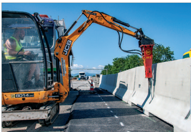
Bild 42: Verankerung der Elemente
