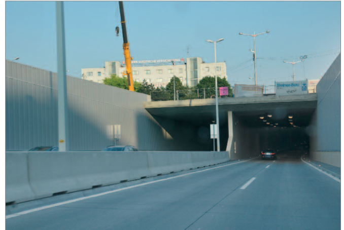
Bild 18: Leitwandanschluss an Tunnelportal
