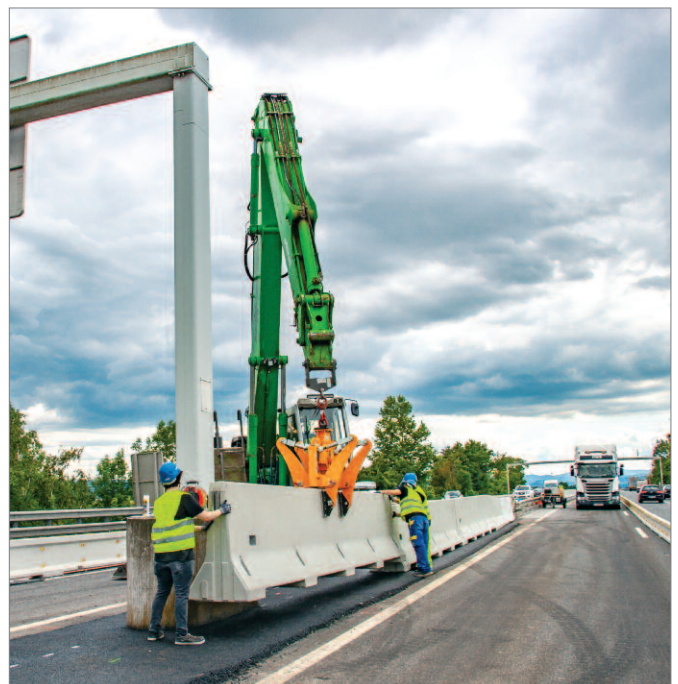
Bild 37: rasche Montage mit Hebezeuge
