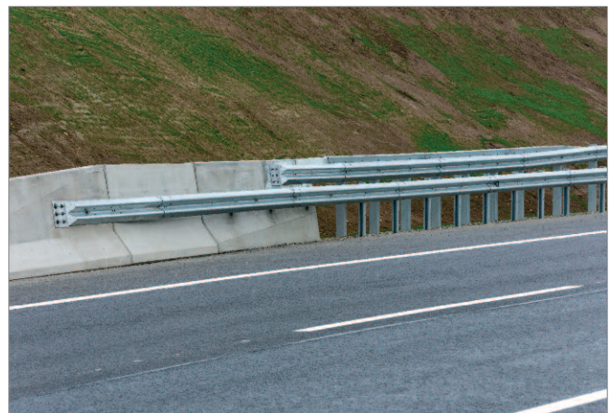
Bild 21: geprüfte Übergangskonstruktion gemäß ÖNORM EN 1317-4
