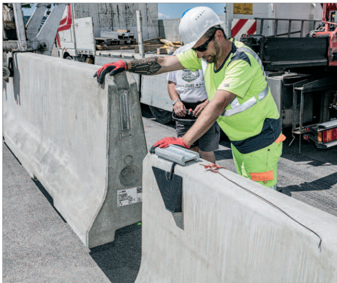
Bild 39: Zusammenschluss der Elemente
