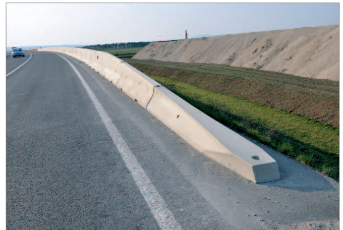
Bild 27: Rampe als Anfangskonstruktion
