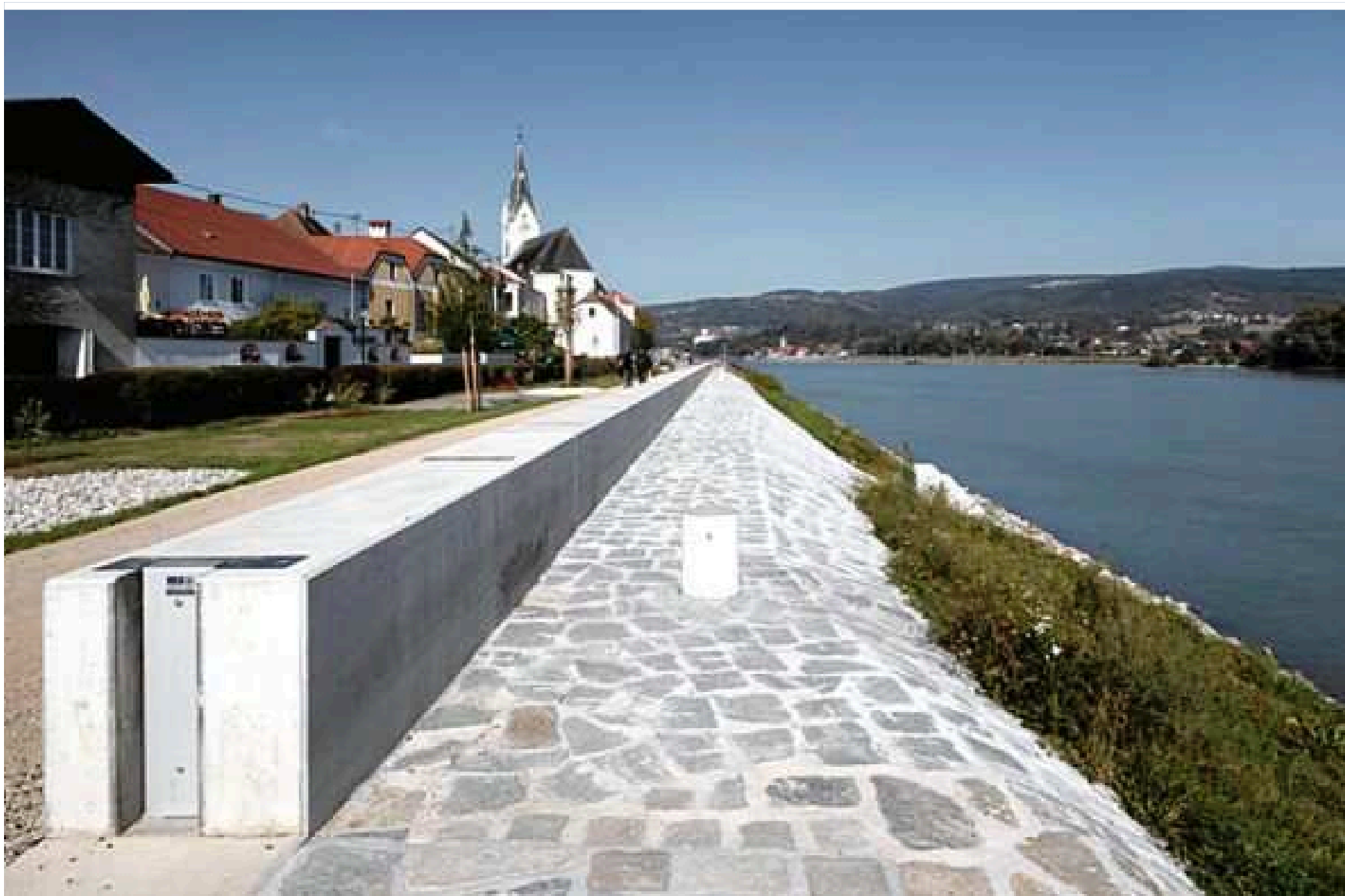
Der Beton aus der Region wird auf kurzen Wegen zum Einbauort, wie etwa diesem Hochwasserschutzbau in Ybbs an der Donau, transportiert und sorgt für vielfältig nutzbare Orte
