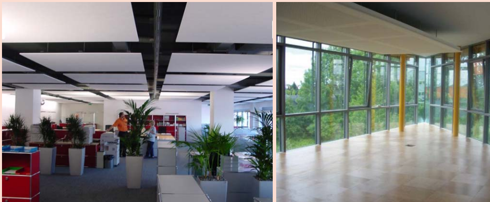
Abbildung 29: Beispiel von der Decke abhängende Akustikplatten (Foto links: Renz GmbH; rechts: alki-Technik-Zentral Ingolstadt, Architektur: Bachschuster Architektur).
