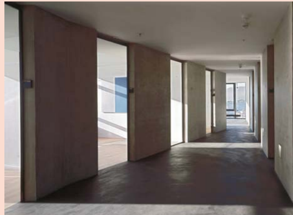
Abbildung 11: Massive Flurtennwände im Turm des Bundesamtes für Statistik, Neuchâtel, Schweiz. (Architektur: Bauart Architekten und Planer AG, Bern. Foto: Ruedi Walti, Basel)
