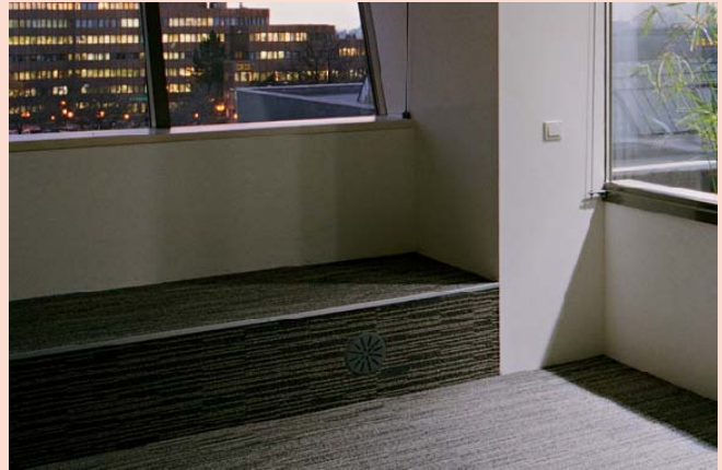
Abbildung 24: Luftauslass für die Quelllüftung im ENERGYbase, Wien. (Foto: Hertha. Hurnaus, Architektur: pos architekten).
