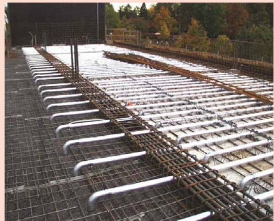
Abbildung 41: Verlegung der Kühlrohre einer luftgeführten Bauteilaktivierung (Quelle: Hildebrand, Kiefer Luft- und Klimatechnik, 2006).
