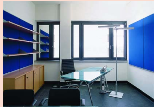
Abbildung 13: Massive Parapete im Bürogebäude (Foto: Paul Ott, Architektur: Ernst Giselbrecht + Partner).
