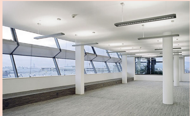
Abbildung 26: Beispiel von Pendelleuchten bei einer massiven Decke im ENERGYbase, Wien (Foto: Hertha Hurnaus, Architektur: pos architekten).
