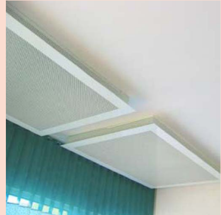
Abbildung 28: Akustikplatte an der Decke (Quelle: Renz GmbH).
