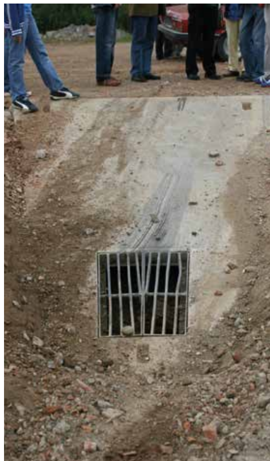
Bild 6: Verkehrssicherer Durchlass nach dem Test
