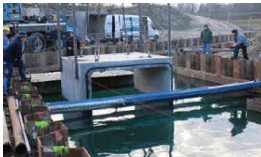
Versetzversuche unter Wasser mit Industrietachern der Nautilus Dive Company
