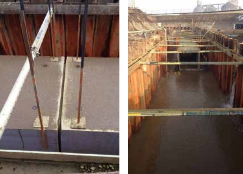
Trockene Baugrube nach Versetzarbeiten ermöglicht Kontrolle der Einbaugenauigkeit im Pilotversuch
