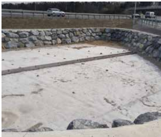
Beispiel: Flächenversickerung mit technischem Filter (begebar)
