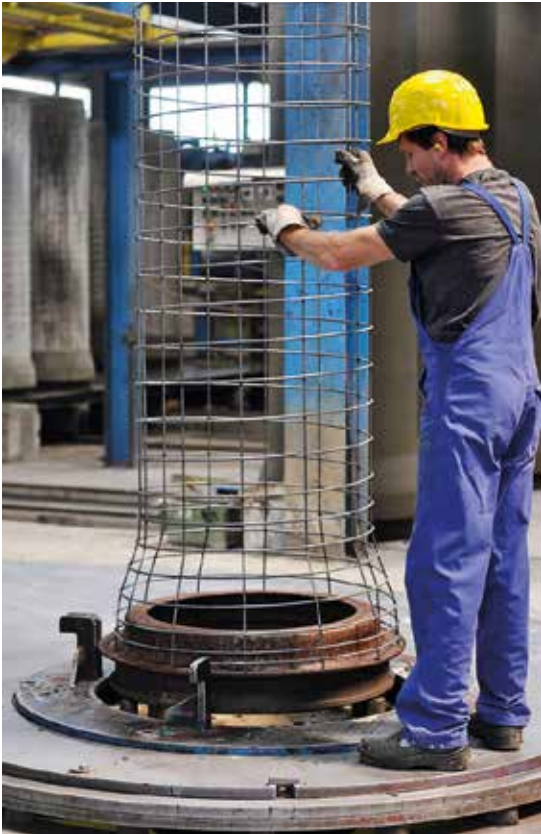
Herstellung der Bewehrungskörbe, Entschalung und Trocknung
