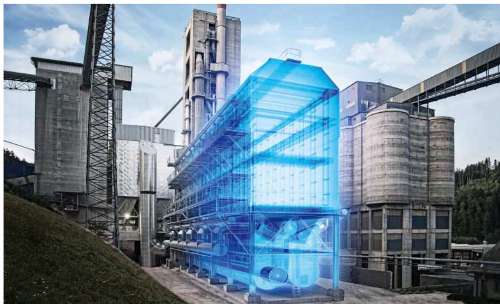
Das Kirchdorfer Zementwerk punktet nicht nur durch seine außergewöhnliche Optik. Rechts die innovative DeCONOX-Anlage, die den CO 2 -Ausstoß verringert und die Abwärme nutzbar macht
