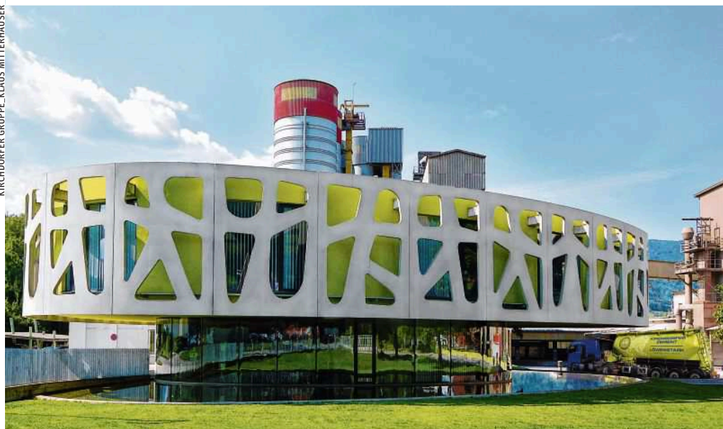
Das Kirchdorfer Zementwerk punktet nicht nur durch seine außergewöhnliche Optik. Rechts die innovative DeCONOX-Anlage, die den CO 2 -Ausstoß verringert und die Abwärme nutzbar macht
